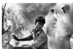
N°36 - Bangladesch, 2011 - Bau einer Asphaltstrasse, ländliche Region
